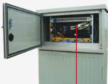
Выпрямитель и оборудование ADSL форм-фактора «pizza box»
